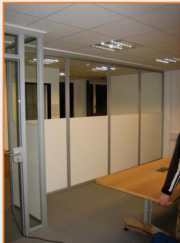
division Trennwände mit Holz / Glasfüllungen in einem Büro
