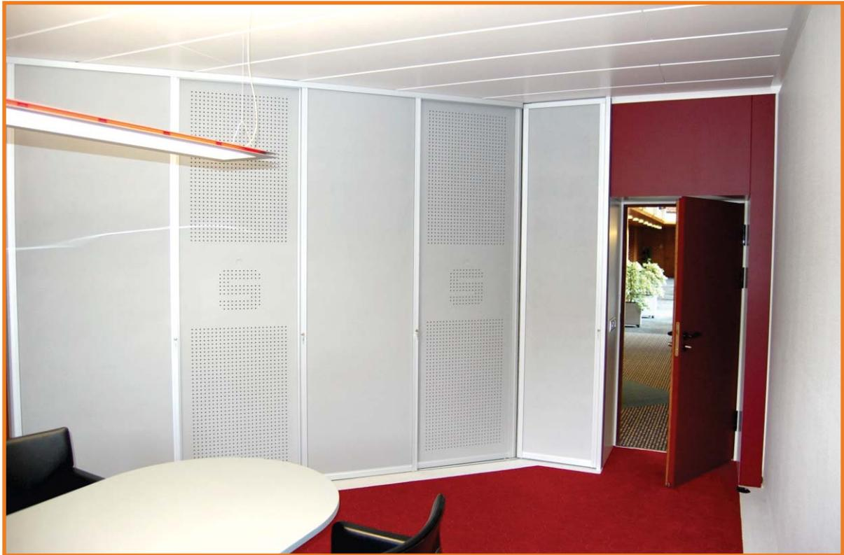
Die Füllungen der Gleittüren sind teilweise mit Bohrungen und einem Akustikvlies versehen. Auf diese Weise ist es gelungen dem Raum eine angenehme Akustik zu geben, ohne die Decke oder Wände aufwendig zu verändern. Die vorhandenen Schränke hinter den division Gleittüren sind unverändert geblieben.
